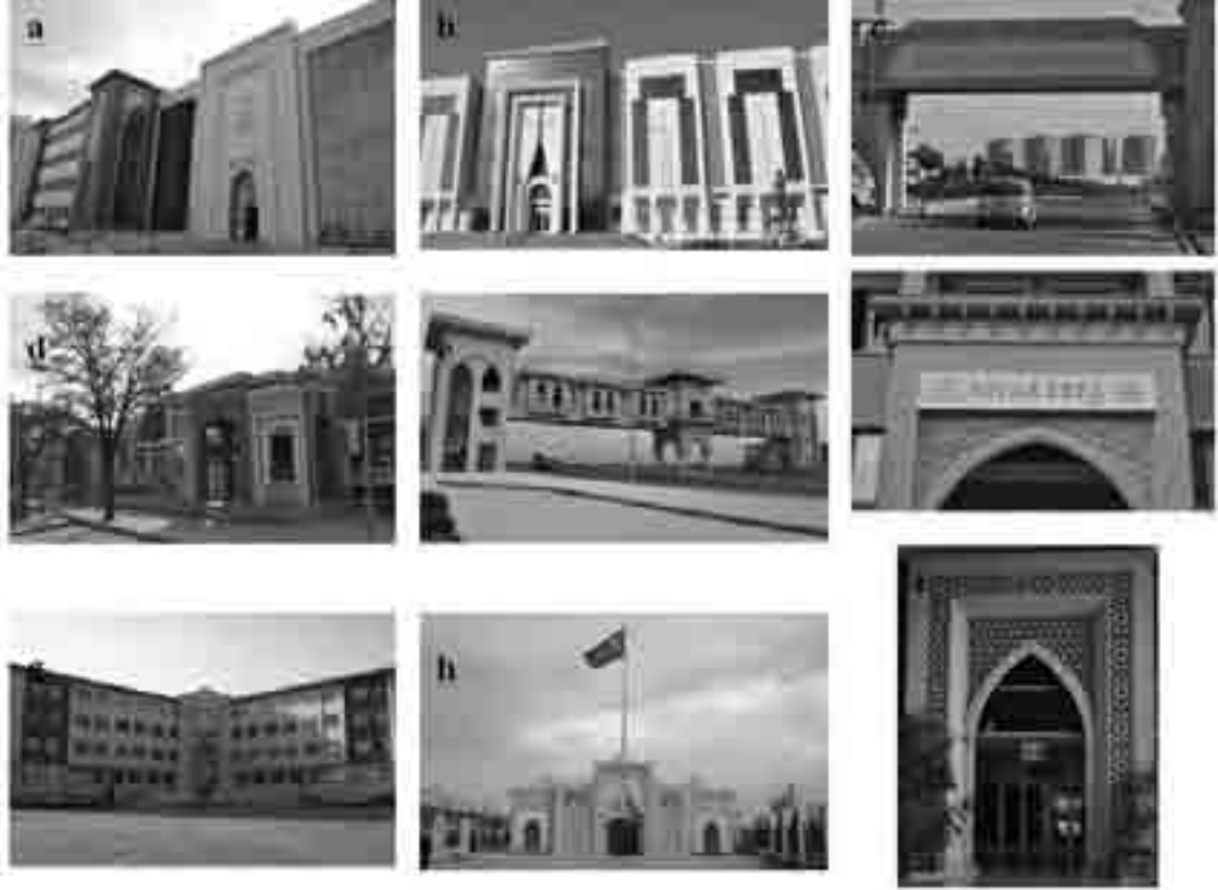
Fotoğraf 1. Selçuklu Dönemi süsleme sanatlarının günümüz tasarım anlayışıyla yorumlanmasına Konya'dan mimari, mimariyi oluşturan öğeler ve süsleme programlarından örnekler (a-Selçuklu Belediye Binası, b-Adliye Sarayı, c-Selçuk Üniversitesi kampüs giriş kapısı, d-Selçuk Üniversitesi kampüs tramvay durağı, e-Selçuk Üniversitesi kampüs-Bosna yaya üst geçidi, f-Niyaz Usta İlköğretim Okulu, g-Mahmud Sami Ramazanoğlu Selçuklu Anadolu İmam Hatip Lisesi, h-Büyükşehir Belediyesi İstiklal Harbi Şehitliği, ı-Rixos iç mekân kapısı)
